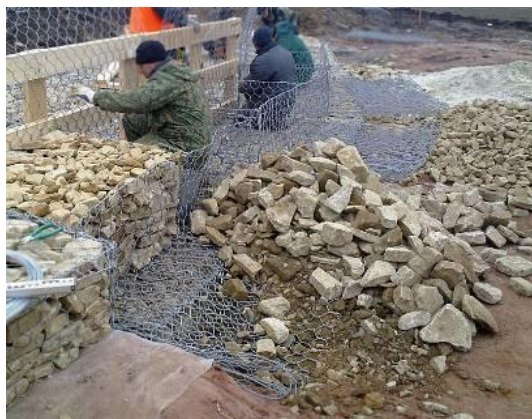
Рис. 2. Устройства габионных конструкций
