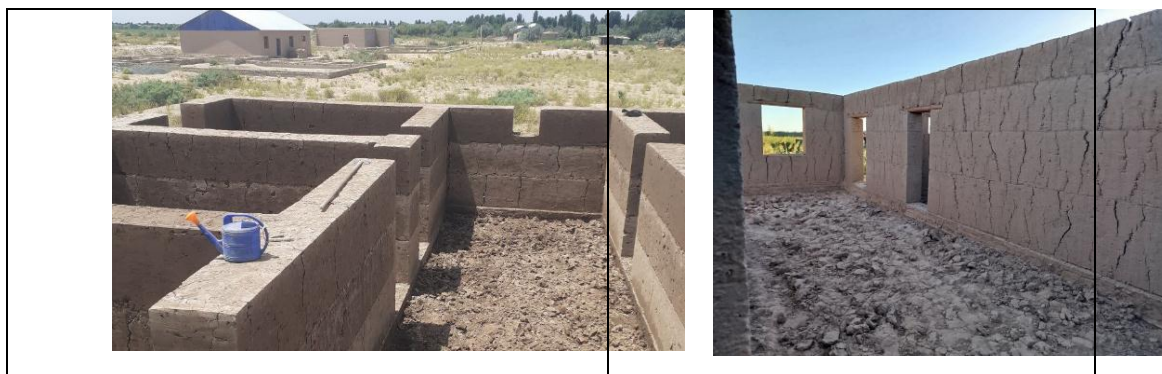
4-rasm. Yangi qurilgan paxsa devorlar
