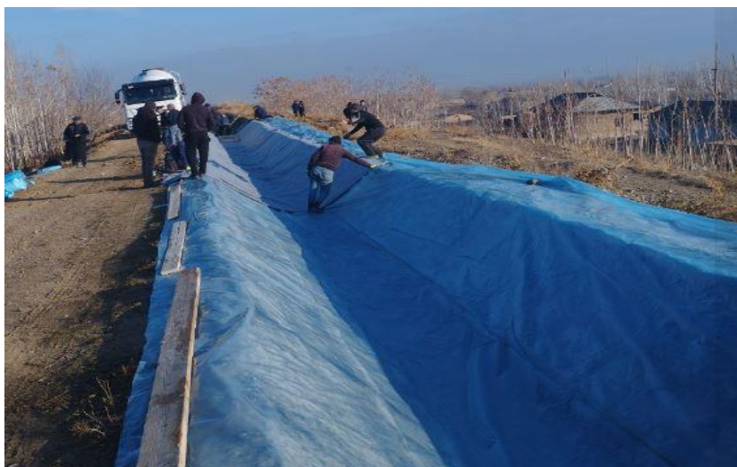
2-rasm. Betonlashtirish uchun tayyorgarlik ishlari
