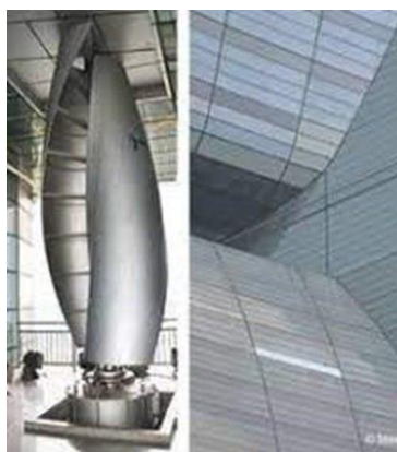
4-rasm. Binodagi teshik fasad qismi deraza o'rnigacha bo'lgan qismi nishablikda shamolni yo'naltirish uchun maxsus qoplama bilan jihozlanadi (chap tomon 1-rasm)
