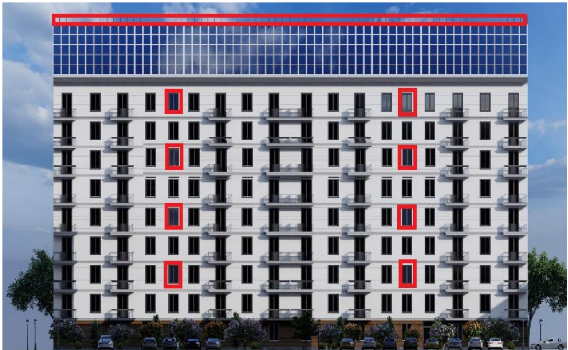
5-rasm. bino fasadi va undagi toq qavatdagi qizil rangdagi teshiklar shamol generatorlari uchun qoldirilgan. tepasidagi bino bo'ylab uzun qizil bilan belgilangan joyda ham shamol generatorlari joylashtiriladi
