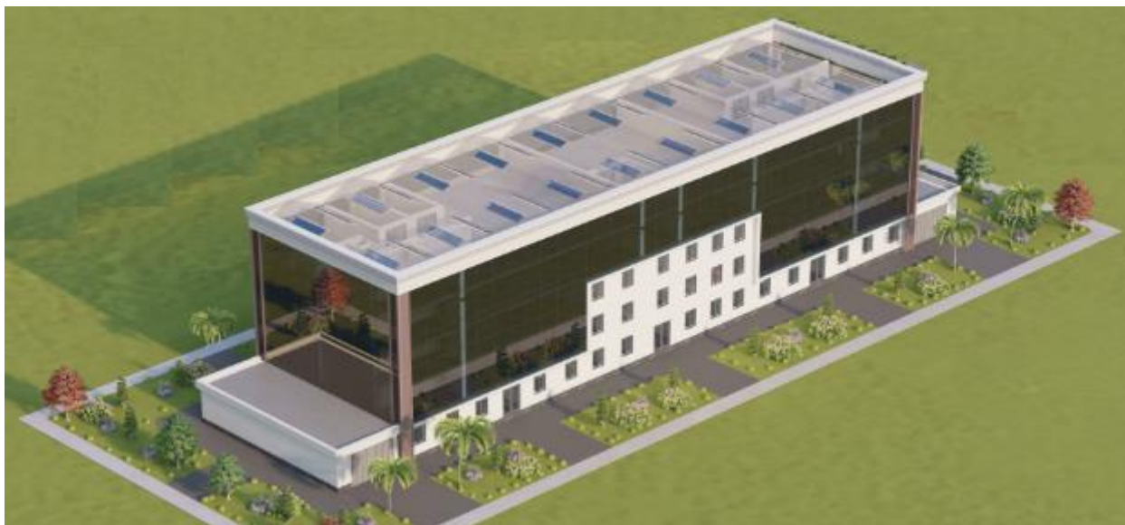
5-rasm. Binoning aksonometrik ko'rinishi va tom qismidagi fanarlar
