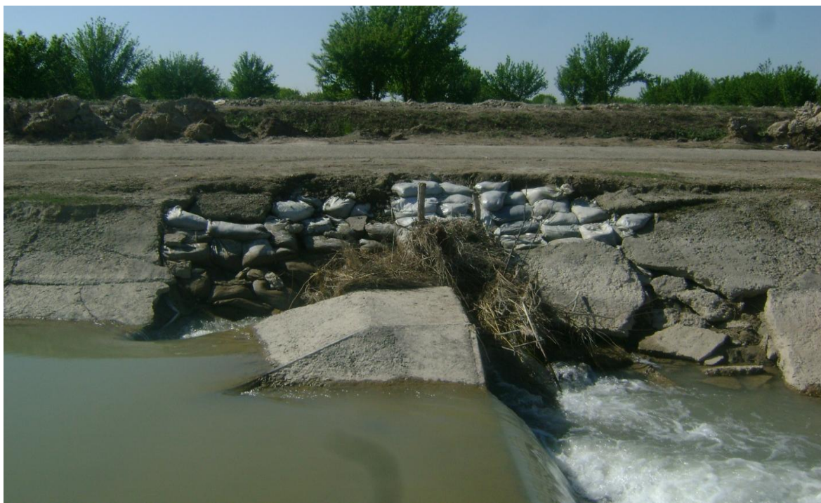
O'zbekiston kanali texnik xolati
