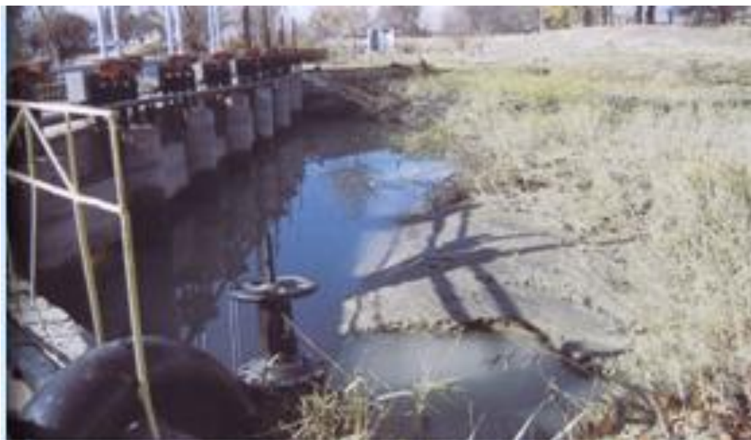
2-rasm. «Kasaba» nasos stansiyasining avankamerasi.
