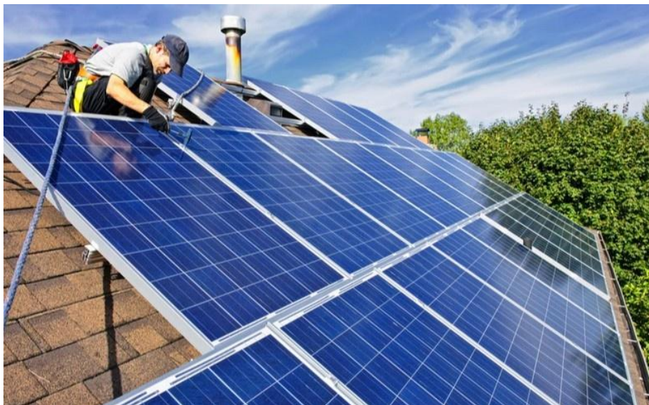
1-rasm. Quyosh panellarinig bino tomiga o‘rnatilishi
