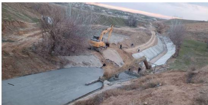
1-rasm. Kanallarni betonlashtirish jarayoni
