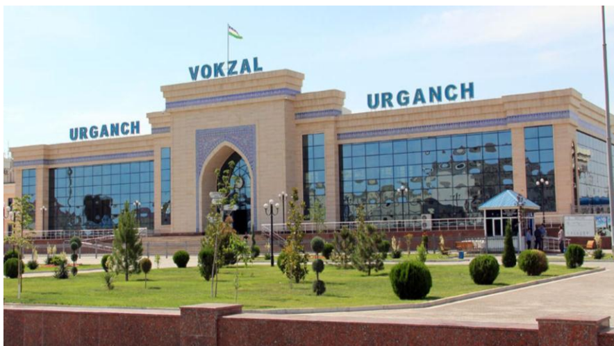
Urganch shahridagi Temir yo'l vokzali
