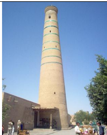
1-rasm. Juma Masjidning kirish qismi va ayvonidagi asosiy yuk ko'taruvchi konstruksiyasi – ustunlarining umumiy ko'rinishi
