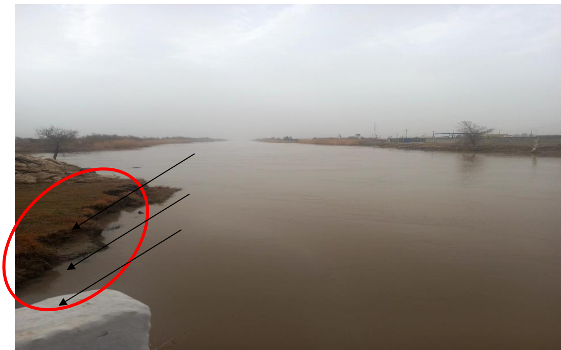
1.1-rasm. Inshootning olib keluvchi kanali qirg'oqlari yuvilish holati.
