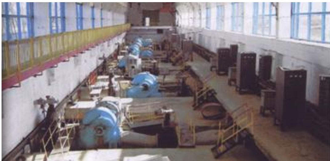
1-rasm. «Kasaba» nasos stansiyasining mashina zalining hozirgi holati
