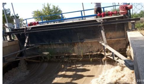
2-rasm. Gidrouzeldagi segmentli zatvor.
